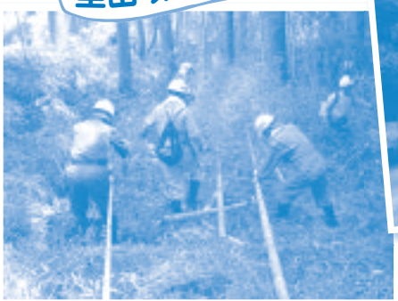
里山 楽山公園遊歩道整備
